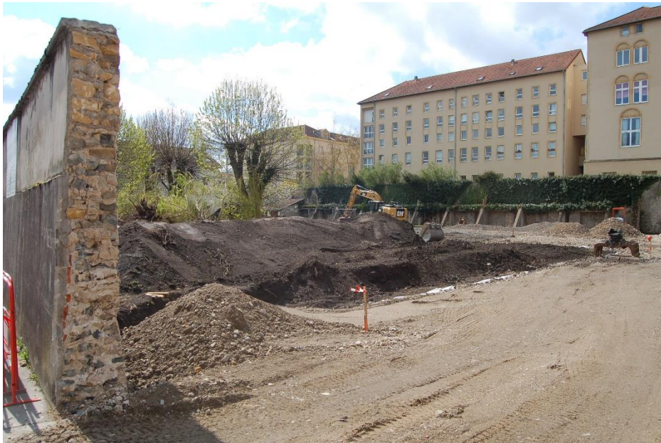
Aperçu des travaux
